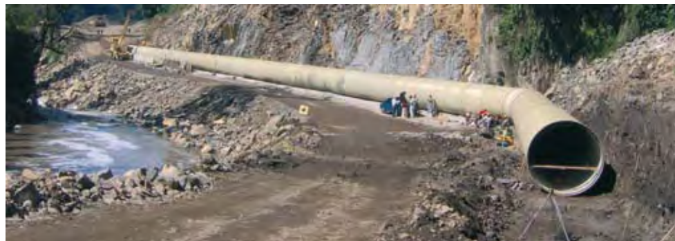
Amiantit 社 (サウジアラビア) は、直径 4 メートルのパイプと、高圧用途への堅固で柔軟なジョイントを製造することができます。
