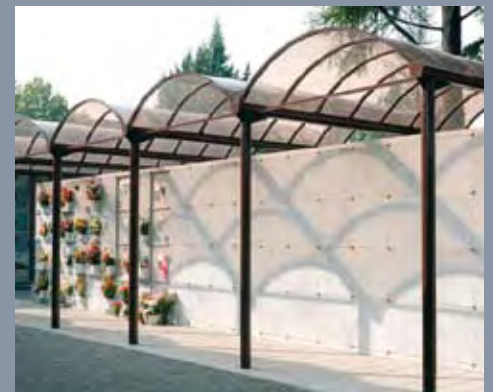
Bosisio Ltd. (イタリア) は、100 基の安置所を数日間で組み立てられるガラス繊維パネルを使った組み立てシステムを開発しました。
