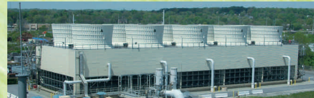
Una de las aplicaciones más grandes de Bedford Reinforced Plastics es la de torres de enfriamiento para centrales eléctricas.
