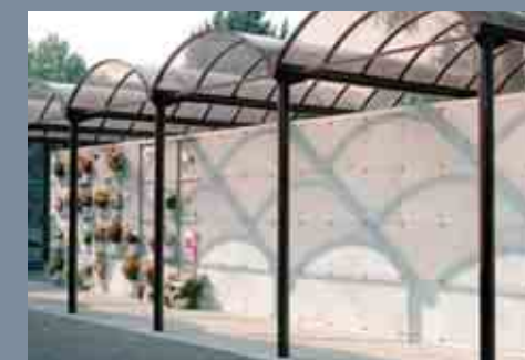
Bosisio Ltd. (Italia) creó un sistema modular con paneles de fibra de vidrio, con los que se puede armar 100 criptas en cuestión de días.
