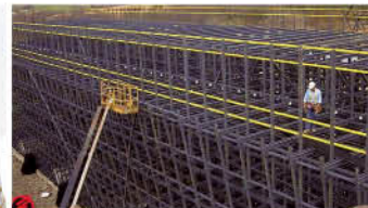
发电厂冷却塔
