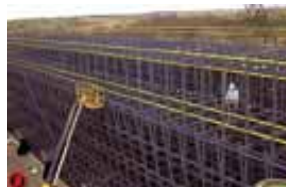
Башенные охладители на электростанциях
