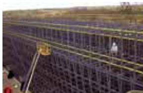
Башенные охладители на электростанциях
